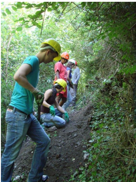
Nettoyage du chemin
