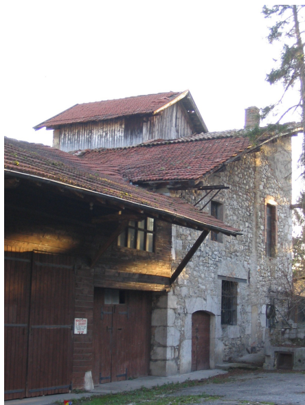
Le moulin, côté cour avant démolition du hangar au premier plan, à gauche de la photo
