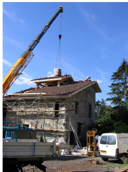
Réfection de la toiture en 2004
