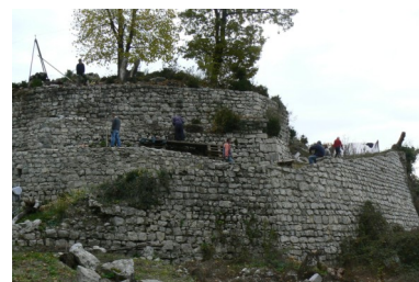
En allégeant le haut de la motte, on préserve la deuxième enceinte
